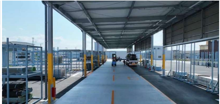
<屋根付き 機材積み下ろしヤード>
