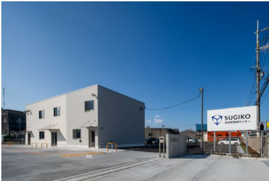
<事務所棟外観>
